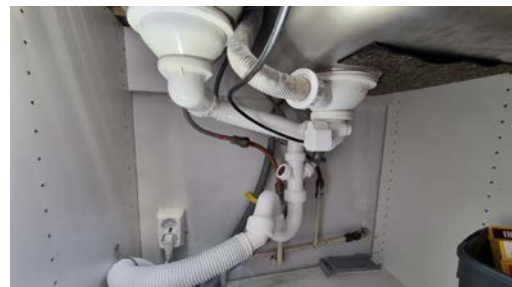
Kontroll av røropplegg under oppvaskkummen.
