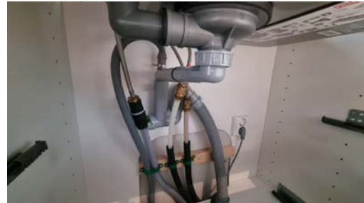
Kontroll av røropplegg under oppvaskkummen.
