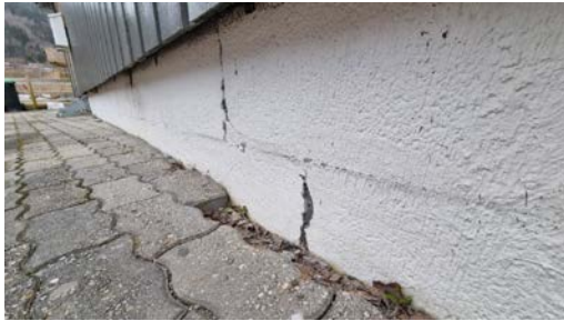
Kontroll av grunnmur under tilbygget del.
