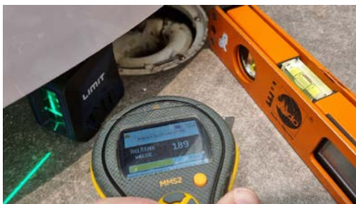
Fuktmåling og kontroll av fall mot sluk.
