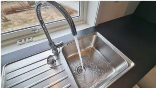
Kontroll av vanntrykk og avrenning.
