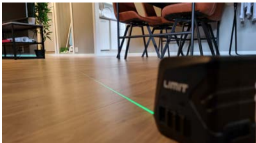
Kontroll av skjevheter med krysslaser, her fra leiligheten i 1. etasje.
