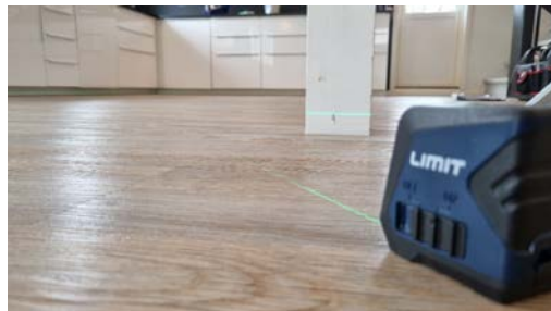
Kontroll av skjevheter med krysslaser, her fra 2. etasje.
