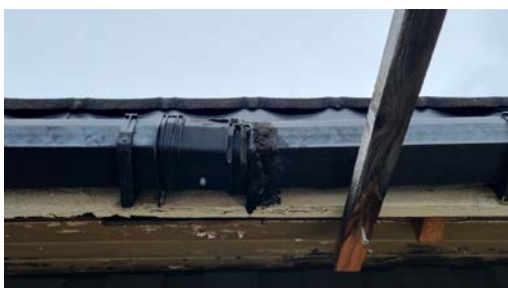
Utettheter i renne.
