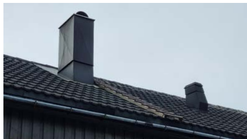
Visuell besiktelse av taket.
