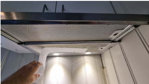
Funksjonstesting av det mekaniske avtrekket over komfyren.
