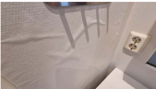
Tapet er ikke tilfredsstillende festet til underlaget.
