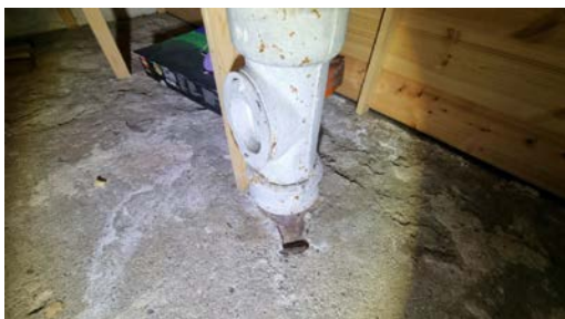
Stakepunkt i kjelleretasjen.
