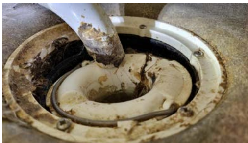
Kontroll av sluk.
