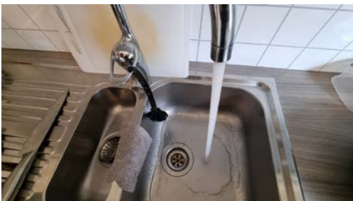
Kontroll av vanntrykk og avrenning.
