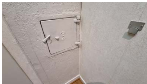
Kontroll av feieluken på loftet.
