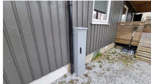
Måler for utleiedel er plassert i utvendig skap.
