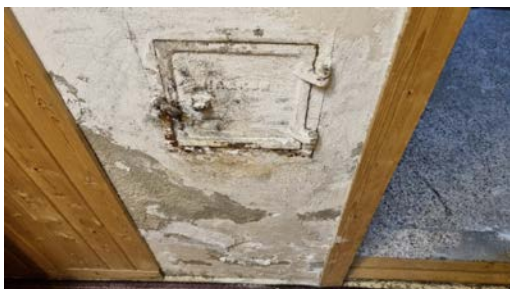
Kontroll av sotluken i kjeller.
