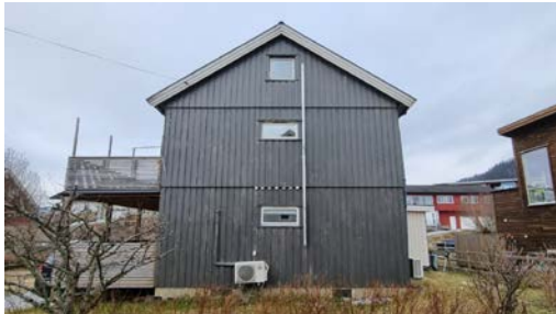
Brannstige montert på fasade sørøst.
