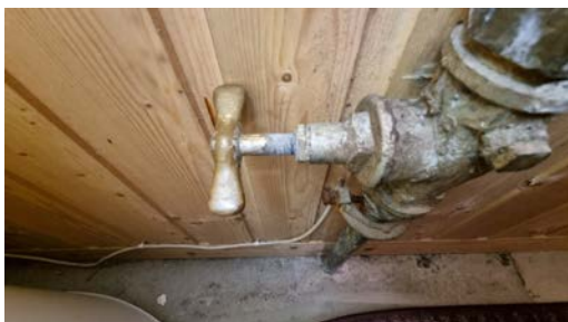
Kontroll av innvendig hovedstoppekran.
