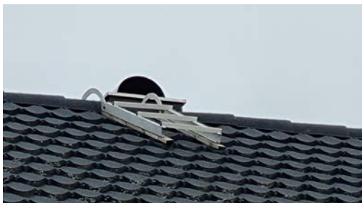
Visuell besiktelse av taket.
