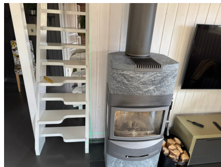
Skjevheter i delevegg.
