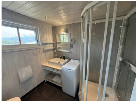
Panel på veggene i våt sone.
