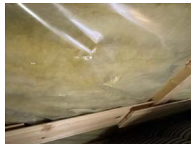
Eksempel på utettheter på dampspennen.
