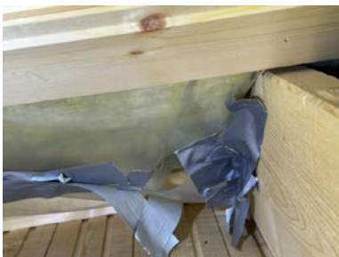
Eksempel på utettheter på dampspennen.
