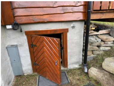
Eksempel på avløpsrør som er avsluttet over bakkenivå ved grunnmuren.
