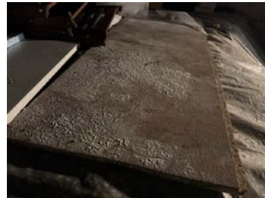
Fuktskader på lagrede materialer.
