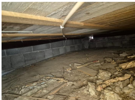
Mangler fuktsperre.
