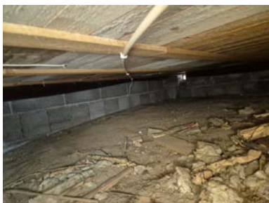
Mangler fuktsperre.
