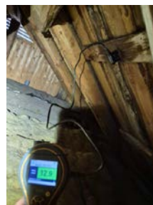
Ikke målt noe unormalt med fukt.
