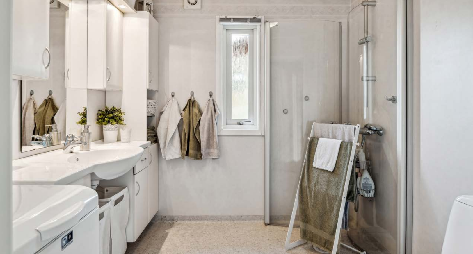
Baderommet som ble pusset opp i 2008 har våtromsbelegg på gulv, overflater med vinylbelegg, et lite vindu og elektrisk styrt vifte.
