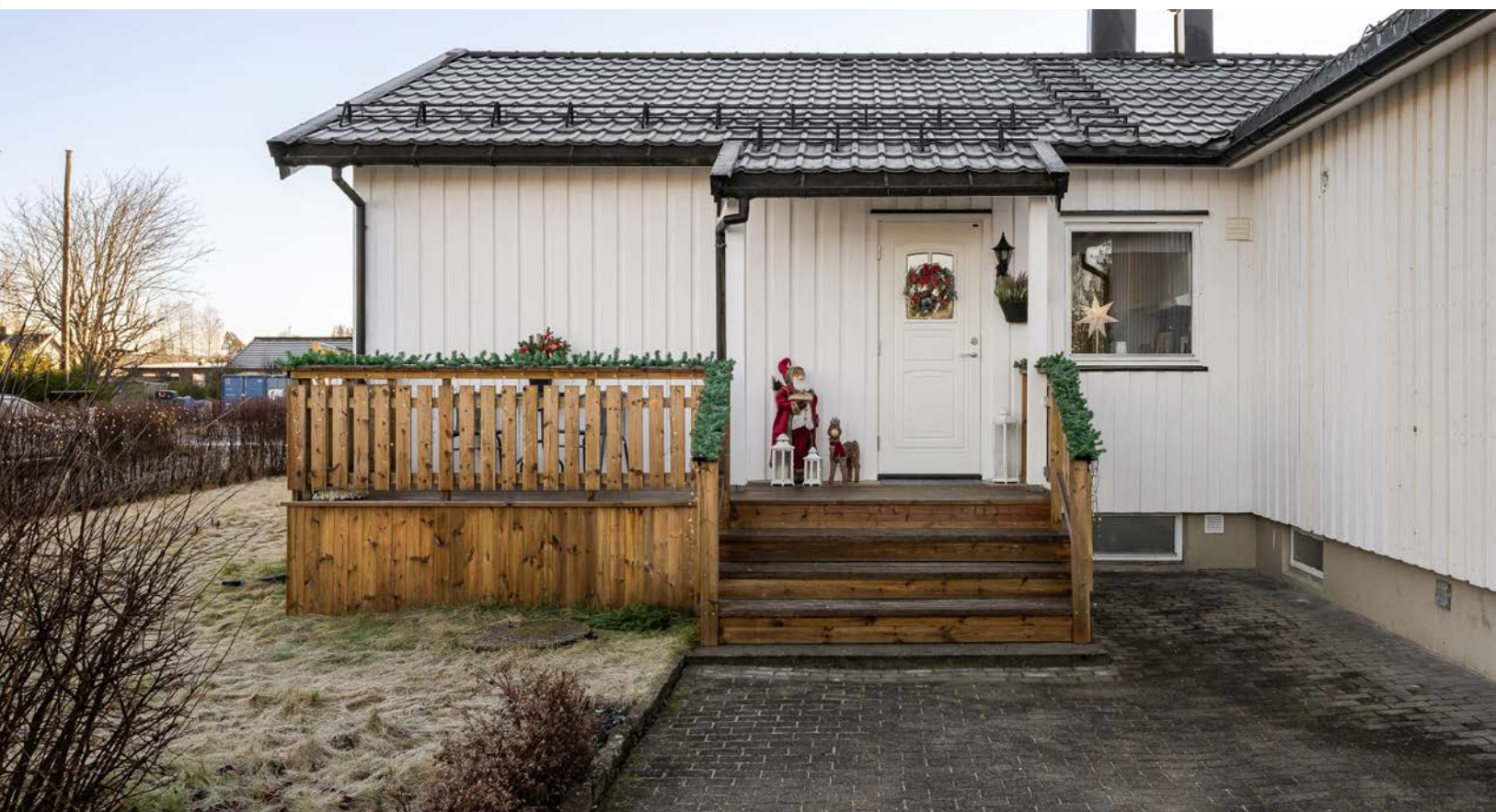
Leilighet 2 ligger i den delen av boligen som ble tilbygget i 1988 og er utleid for kr. 15 000,-/mnd.
