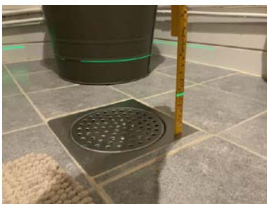
Målt fall til sluk: 18mm.
