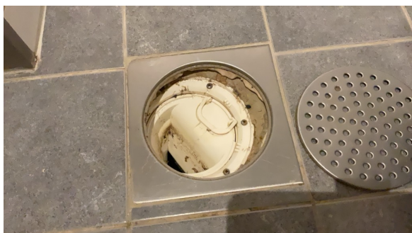
Kontroll av sluk.
