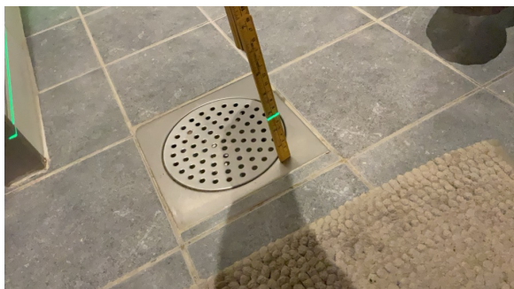
Målt fall til sluk: 18mm.
