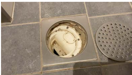
Kontroll av sluk.
