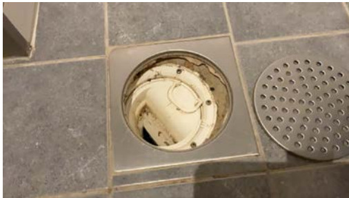
Kontroll av sluk.
