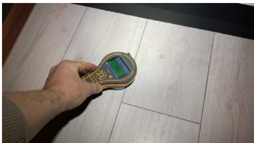
Med enkle fuksøk ble det ikke registrert unormale verdier.
