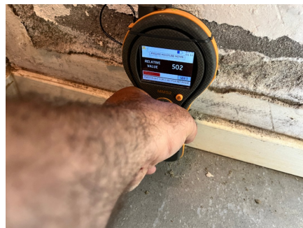
På vegg i bod mot nordøst.
