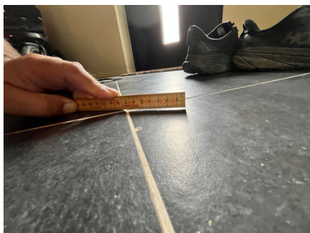
Hakk på flis og ujevn høyde.
