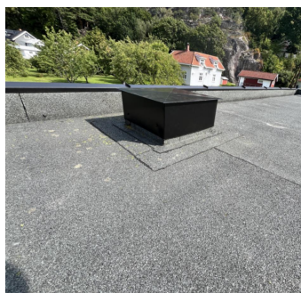
Gjennomføring i tak etter tidligere pipe.
