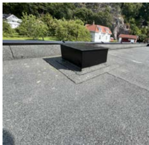
Gjennomføring i tak etter tidligere pipe.
