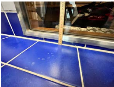
Oppkant under dør til badstue
