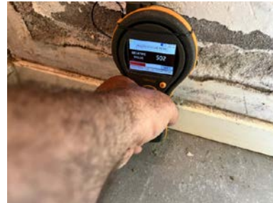
På vegg i bod mot nordøst.
