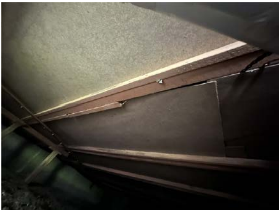
Bilde av stubbloftsplater under bad. Det er ikke synlige fuktmerker ved befaring.
