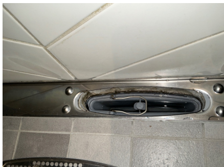
Kontroll av slukrenne
