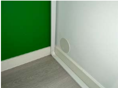
Hull ble plombert med plastlokk.
