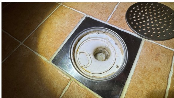
Kontroll av sluk.
