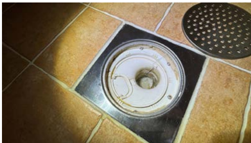
Kontroll av sluk.
