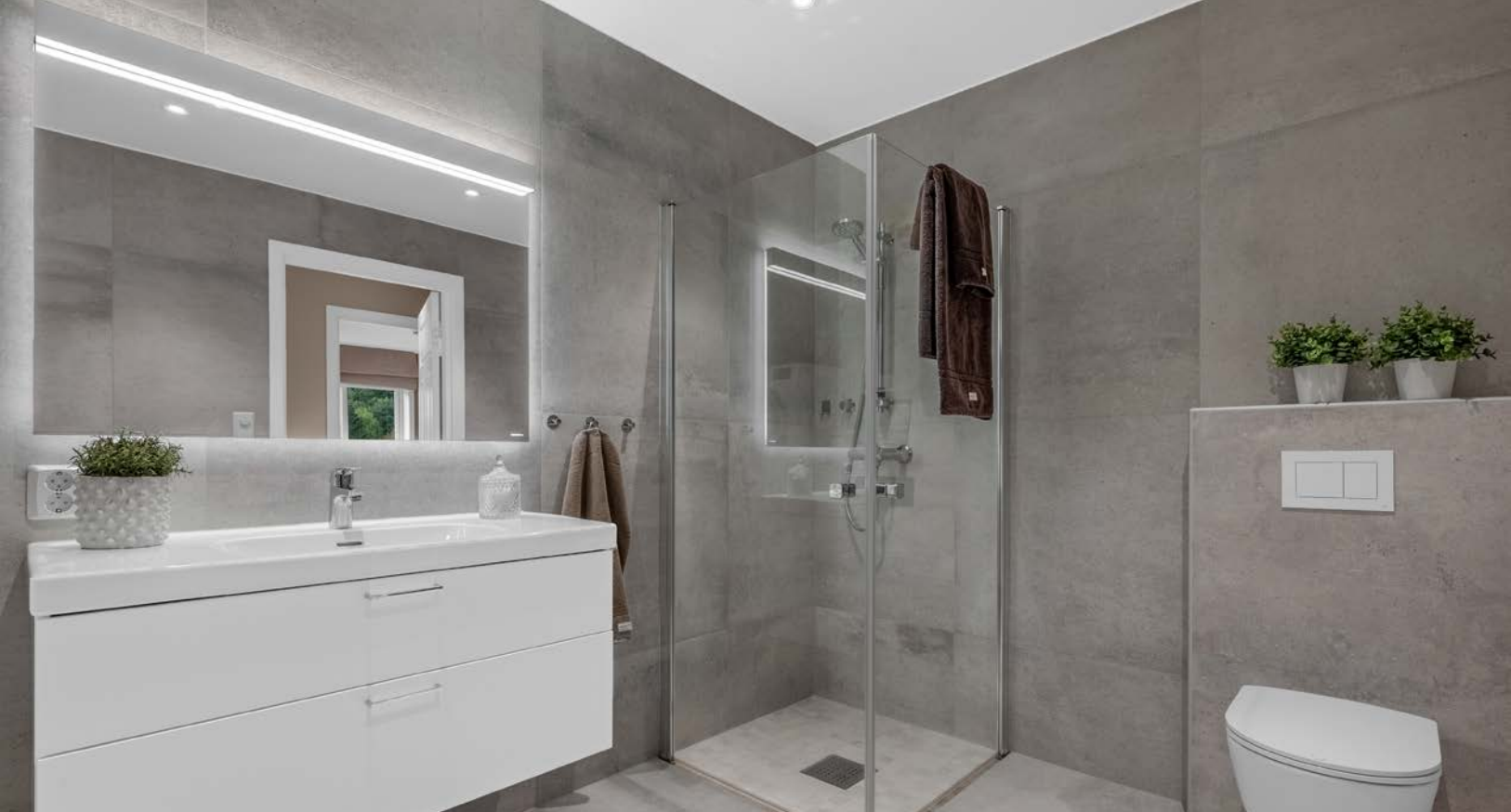
Flislagt bad med fliser i 80x80. Utstyrt med varme i gulv, servantskap, dusjhjørne og vegghengt toalett.
