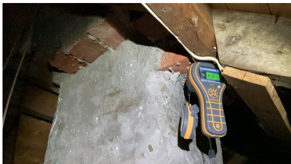
Pusset pipe. Ingen tegn til fukt rundt pipen
