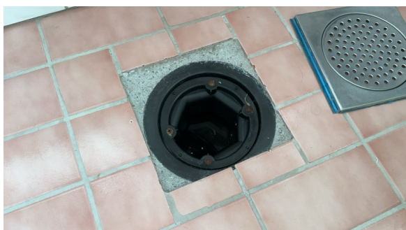
Sluk uten membran
