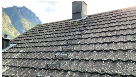
Slitasje på stige-trinn og renner
