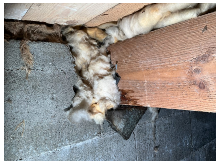
Fuktskader i bjelken i front av bygget.
