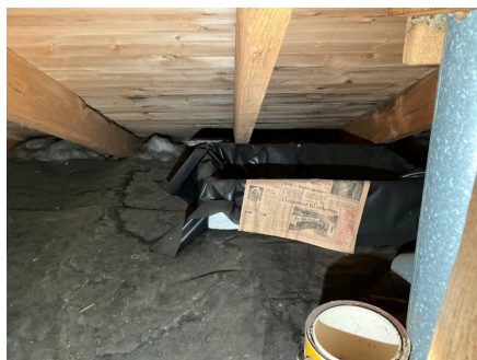
Bøtte plassert på undersiden av lufteplyre.
