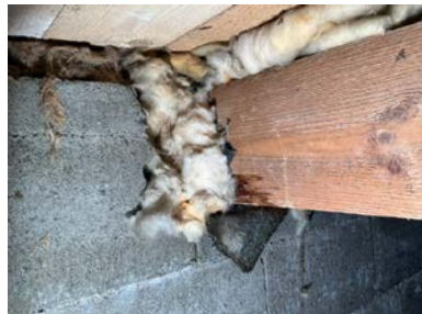
Fuktskader i bjelken i front av bygget.
