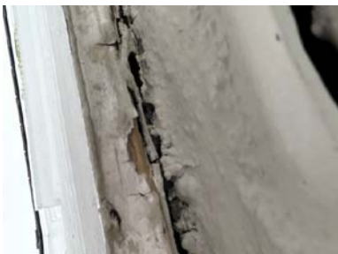
Vann trenger inn mellom vegg og gulv ved inngangen.
