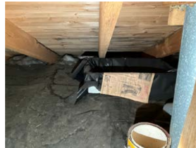
Bøtte plassert på undersiden av lufteplyre.
