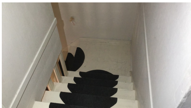
Trapp mellom 1 og 2 etg
