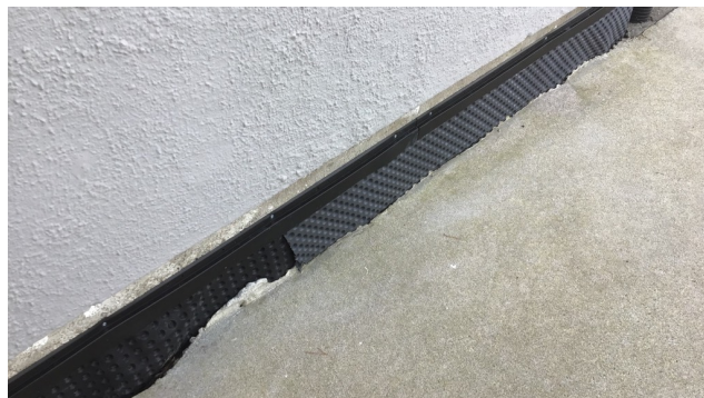
Synlig grunnmursplast med klemlist
