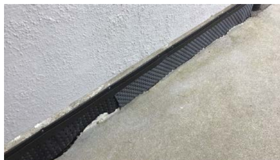
Synlig grunnmursplast med klemlist
