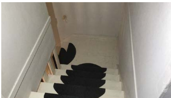
Trapp mellom 1 og 2 etg
