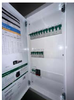
Sikringsskap med automatsikringer.
