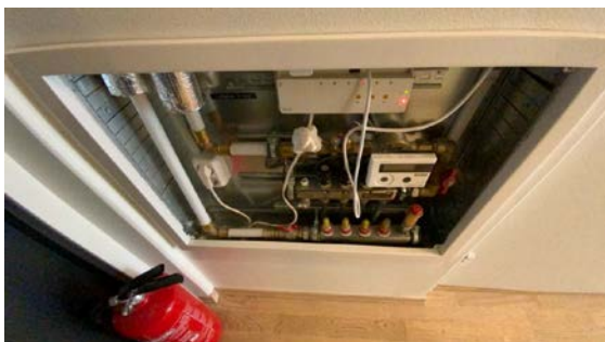
Besiktigelse av røropplegg.
