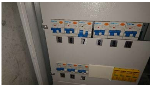
Sikring «Lys 2 etg» lagt ut. (Lys i 2 etg virker.)
