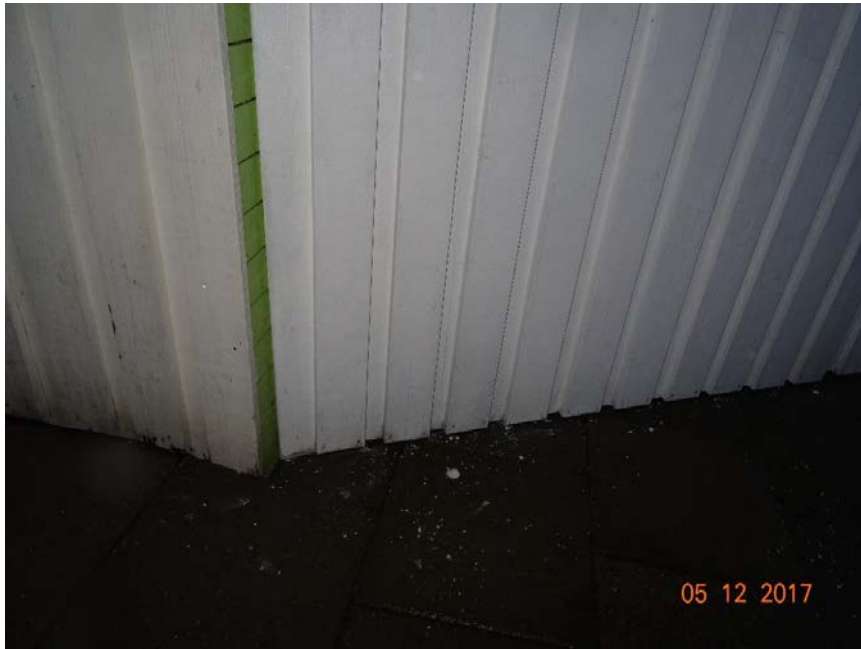
Kledning med liten eller ingen avstand til bakken.
