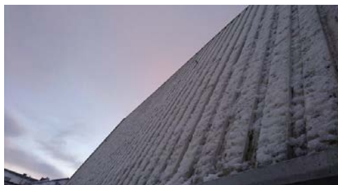
Sprinkler med ukjent frostsikring.
