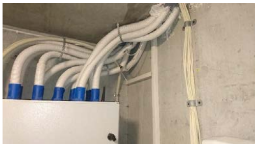
Ikke fagmessig branntetting.
