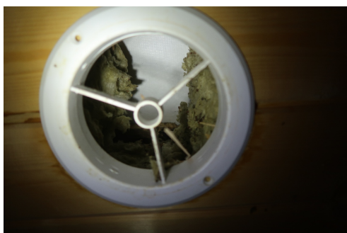
Bilde viser tidligere gjennomføring av avtrekk fra badet.
