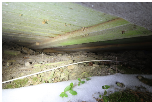
Bilde viser lav høyde i krypekjeller.
