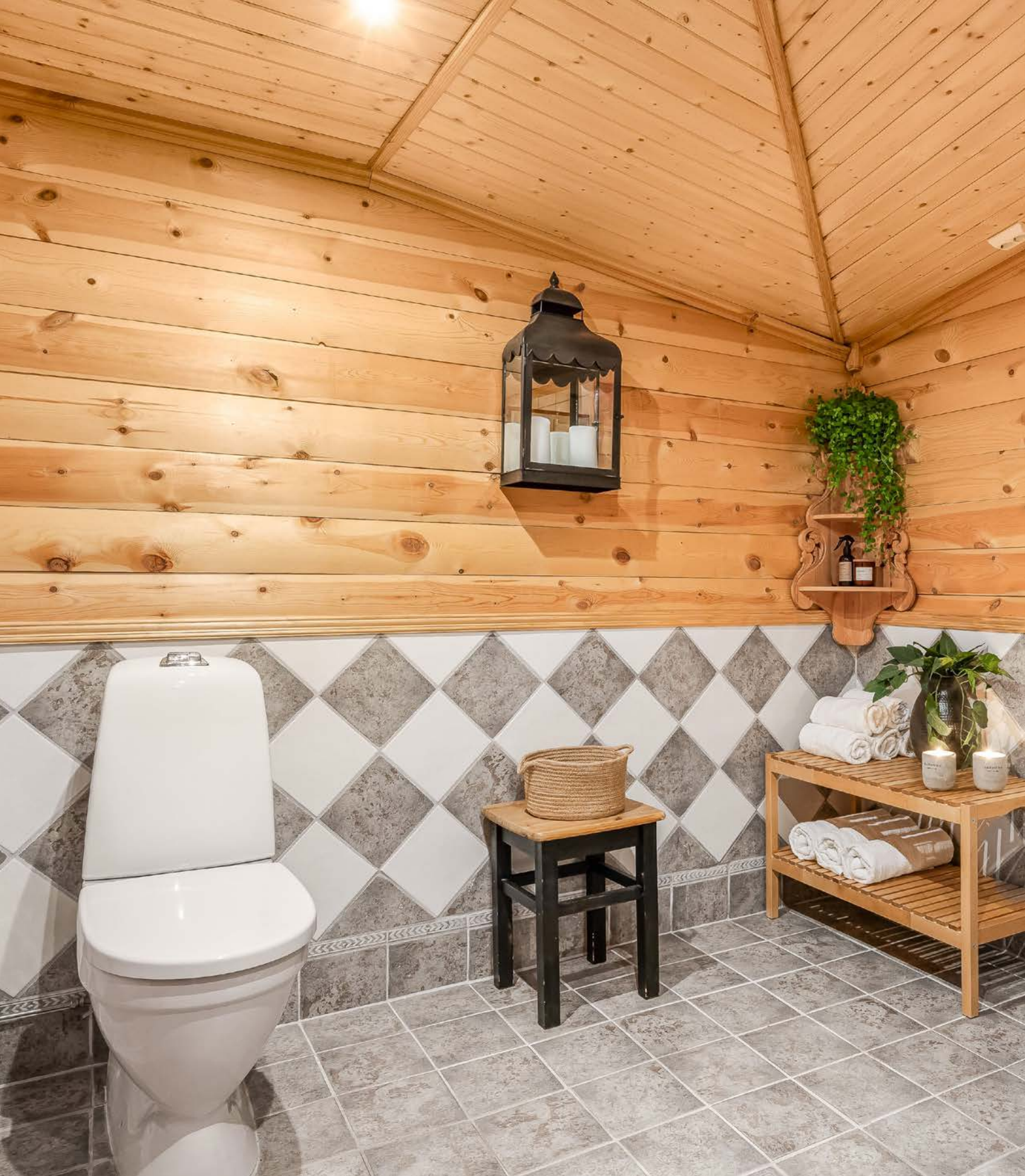
Baderommet har panel/tømmer på veggene og panel i himlingen.
