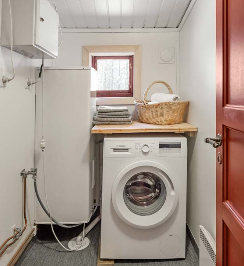
Praktisk vaskerom/tekniskj rom med opplegg for vaskemaskin etc.
