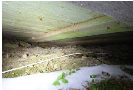
Bilde viser lav høyde i krypekjeller.
