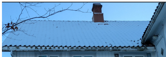
Snødekt tak på befaringsdag
