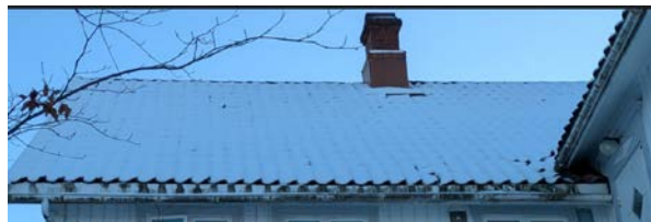
Snødekt tak på befaringsdag
