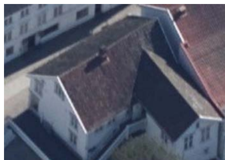
taket er tekket med enkelkrum tegltaksten
