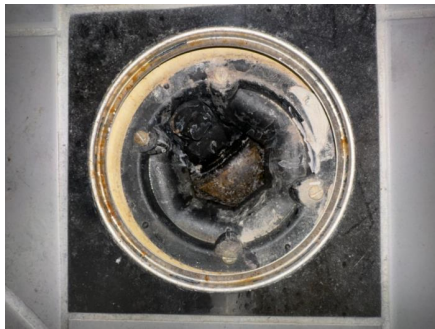
Plastsluk med stakemutter fra byggeår og originalt linoelumsbelegg
