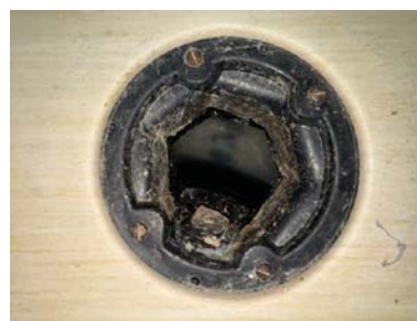
Plastsluk med stakemutter fra byggeår og originalt linoleumsbelegg
