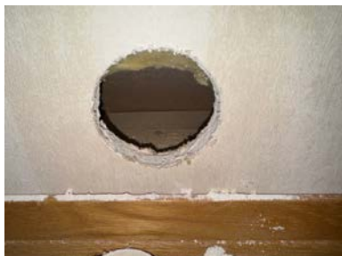
Hulltaking i tilstøtende kjøkken
