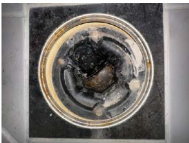
Plastsluk med stakemutter fra byggeår og originalt linoleumsbelegg
