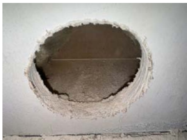
Hulltaking i tilstøtende bod
