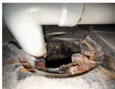
Plastsluk med stakemutter fra byggeår og originalt linoelumsbelegg
