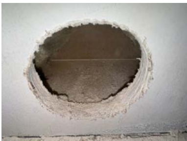
Hulltaking i tilstøtende bod
