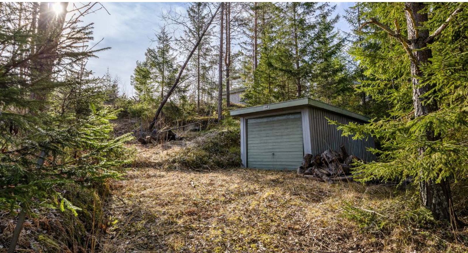
Tilhørende eldre garasje på eiendommen.
