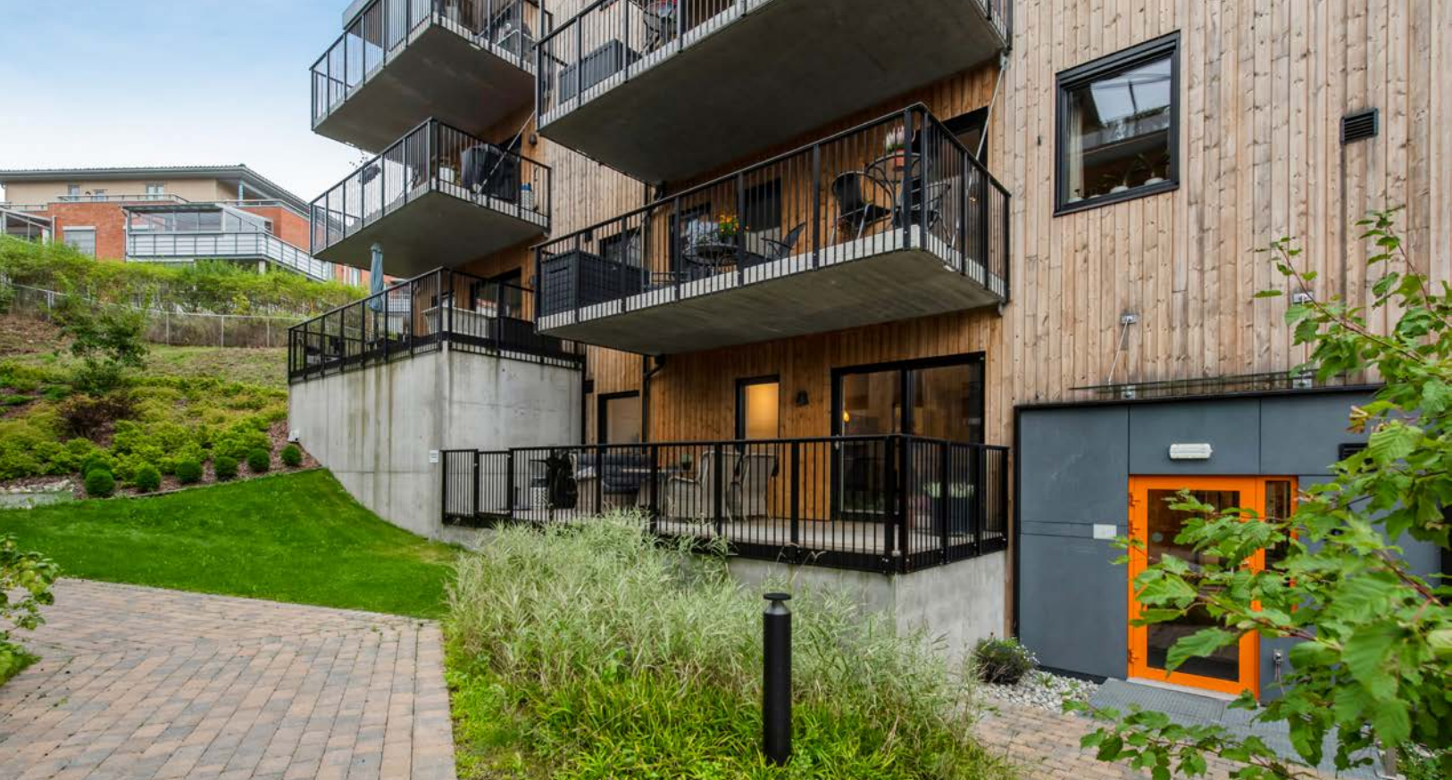
Takoverbygget veranda med rekkverk at stående spiler i lakkert stål og glass, port i rekkverk, samt utelys og stikkontakt.
