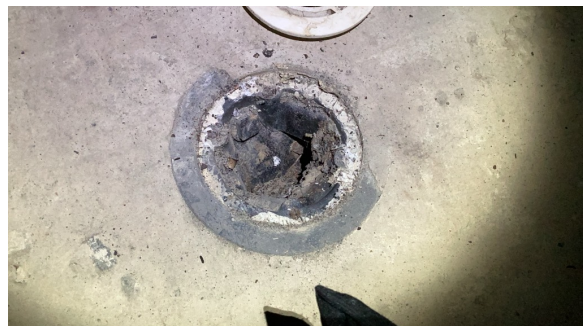
Sluk på bod i kjeller.
