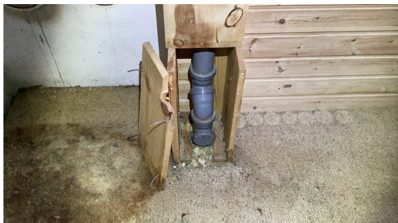
Stakeluke i kjeller.
