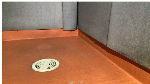
Fuktskader på plater.
