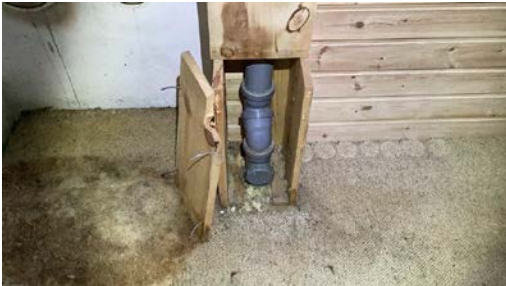
Stakeluke i kjeller.
