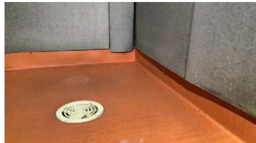
Fuktskader på plater.
