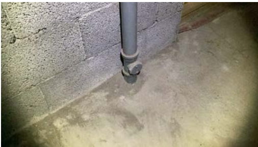
Stakeluke i kjeller.
