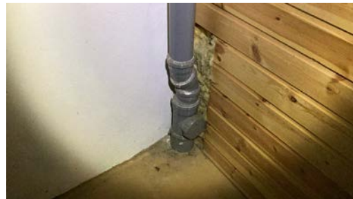
Stakeluke i kjeller.
