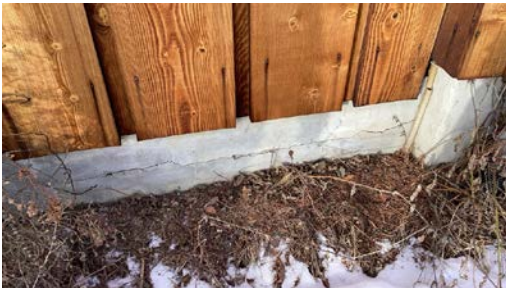
Sprekk i gulv.
