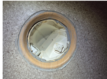
Belegg ikke klemt i sluk.
