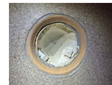
Belegg ikke klemt i sluk.
