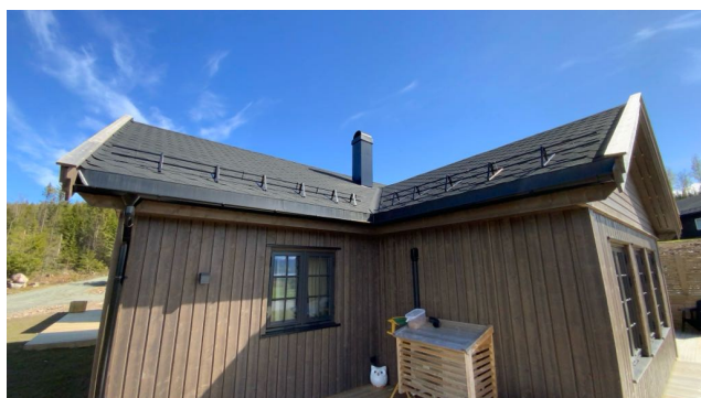
Besiktigelse av taktekke.
