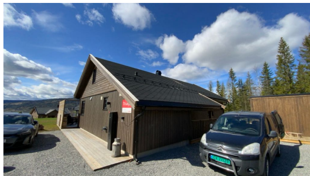
Besiktigelse av taktekke.
