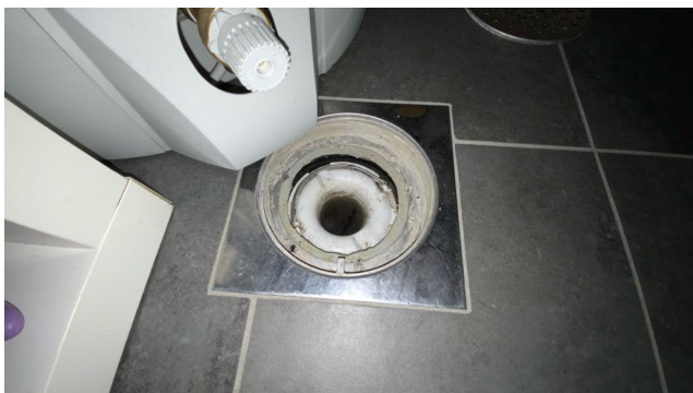
Kontroll av sluk.
