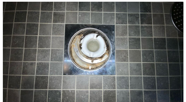
Kontroll av sluk.
