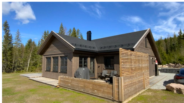
Besiktigelse av taktekke.
