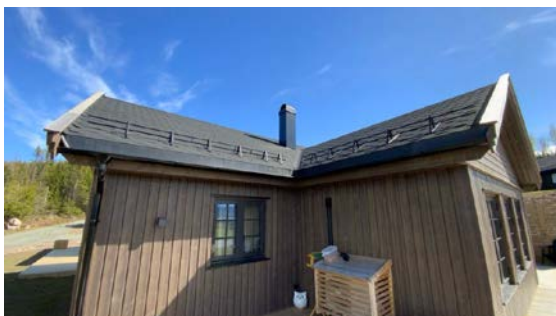
Besiktigelse av taktekke.
