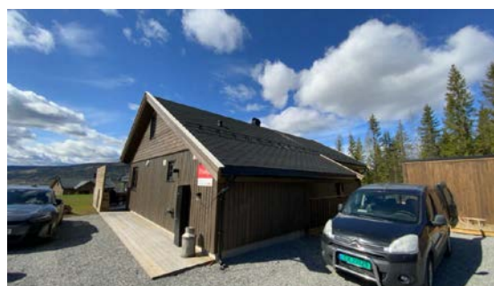
Besiktigelse av taktekke.
