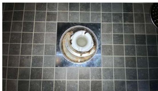
Kontroll av sluk.
