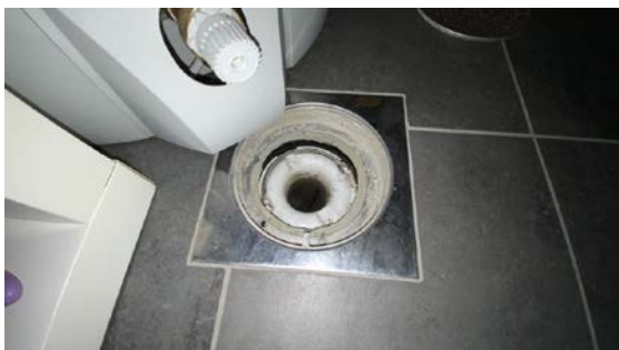
Kontroll av sluk.
