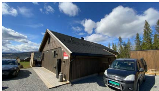
Besiktigelse av taktekke.
