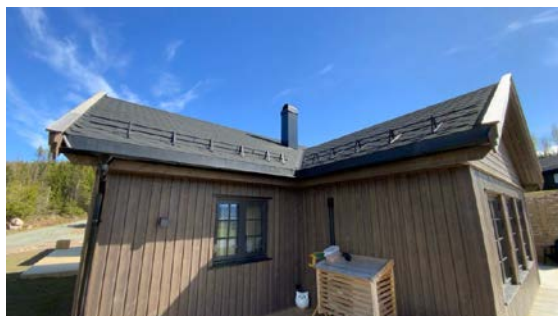
Besiktigelse av taktekke.
