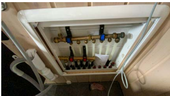
Besiktigelse av røropplegg.
