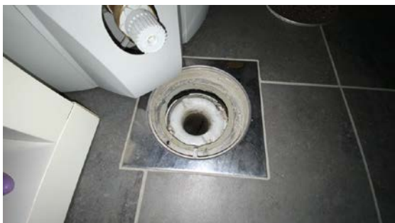
Kontroll av sluk.
