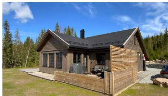
Besiktigelse av taktekke.
