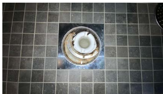
Kontroll av sluk.
