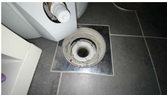
Kontroll av sluk.
