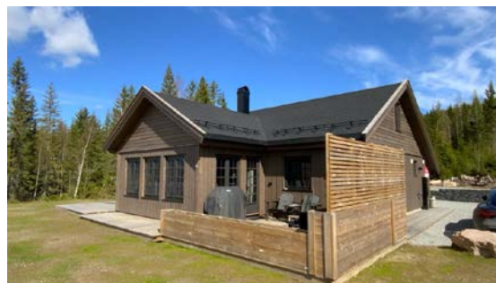
Besiktigelse av taktekke.
