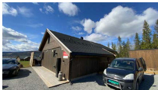
Besiktigelse av taktekke.
