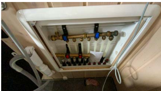
Besiktigelse av røropplegg.
