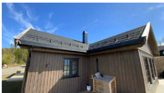
Besiktigelse av taktekke.
