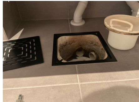
Hovedsluket under innredningen
