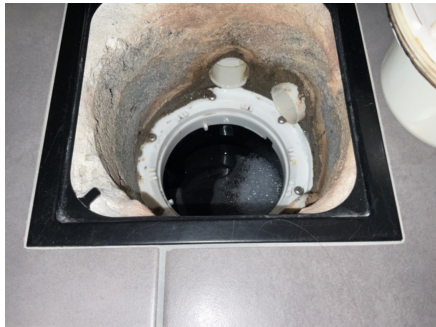
Hovedsluket under innredningen
