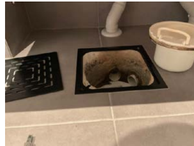
Hovedsluket under innredningen
