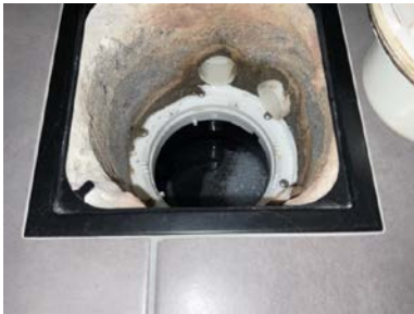
Hovedsluket under innredningen
