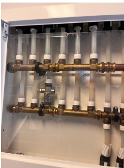
Rørkurser er ikke merket i fordelerskapet.
