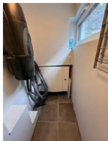
Rør fra radonbrønn under den lille flisen?
