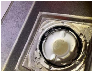
Synlig mansjett under klemring i sluket.
